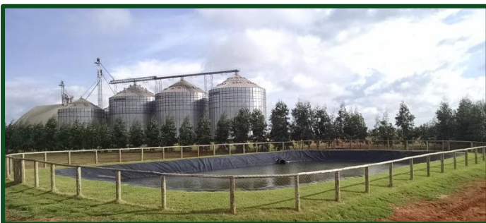
Tanque de captação de água da chuva localizado na sede da fazenda.
